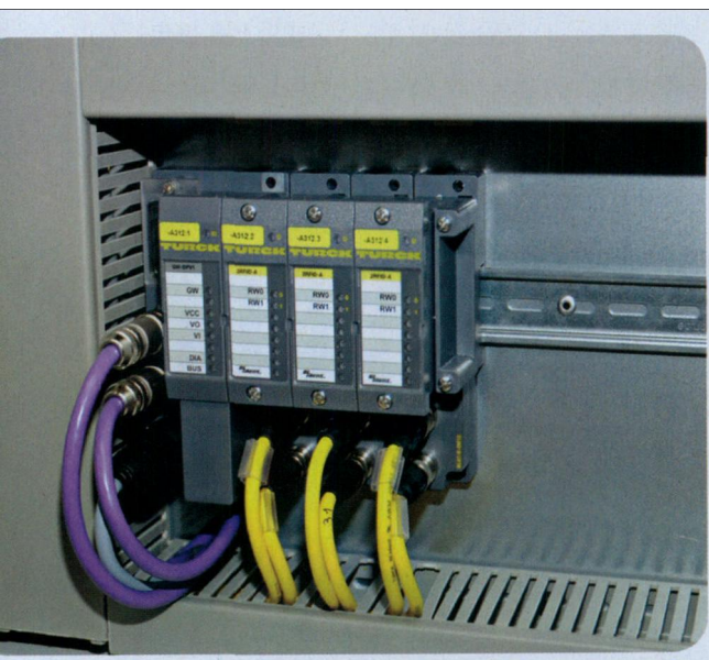
当RFID技术被置于标准传感器外壳内,对于那些熟知流水线传感器安装的操作人员来说,它就更便于使用了。
