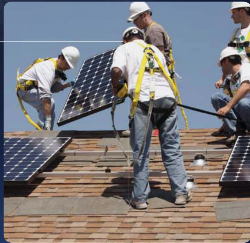
应用材料公司的员工为低收入家庭安装太阳能电池板。
