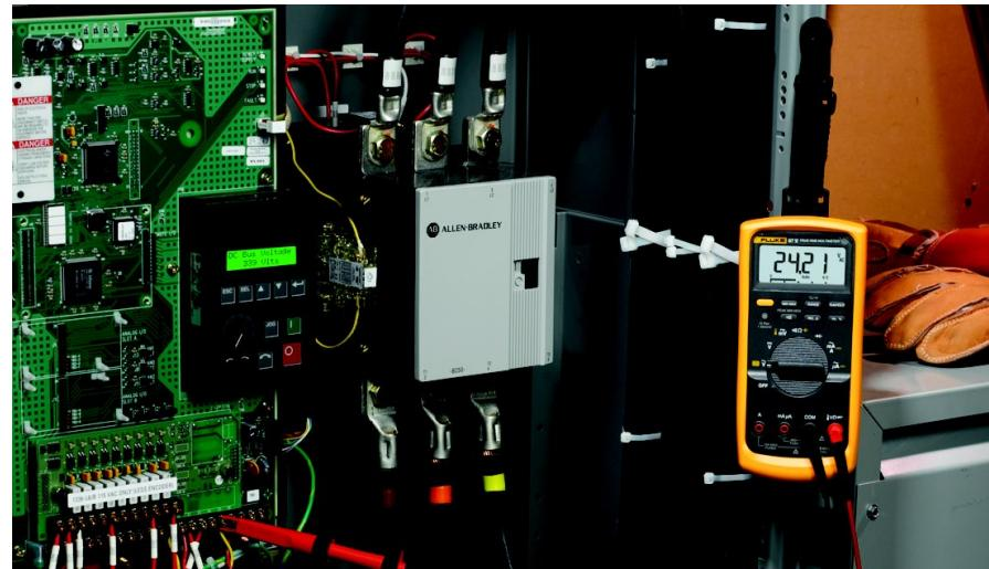
会碰到令人困惑的连接问题。但是，您也可以安排此类检查，以进行预测和预防性维护。接地系统、电力配送系统、控制器，和过程测量仪器设备都会从接头监控中获益非浅，因此，您可以纠正连接质量缺陷，以免出现故障。
