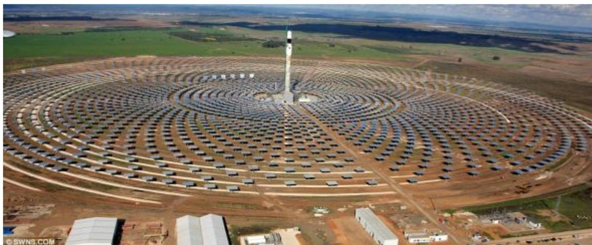
夜间发电：与其他所有太阳能电站不同的是，存储于吉马太阳能电站熔盐池中的热量持续释放的时间可以超过 15 个小时，从而在整个夜间或没有阳光的情况下也可以保证电站正常发电。【详情：西班牙建夜间太阳能发电站年发电 1.1 亿千瓦时】
