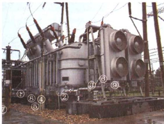
图1 智能化变压器传感器分布示意图
