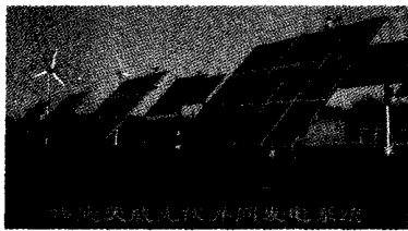
图5 太阳能跟踪系统光伏发电阵列
