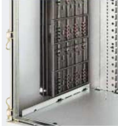
图 13: 安装在柜体左侧的具有电弧故障防护的接插母线系统
