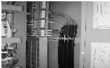
图 4 光缆排布接线
