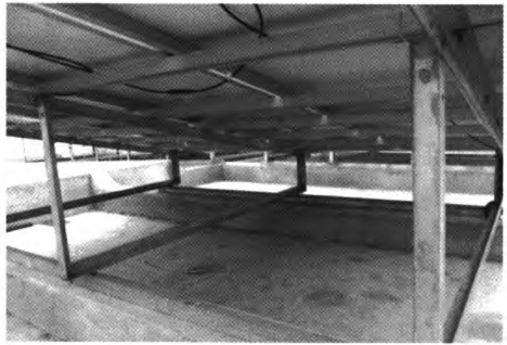
图9 电池组件、底座和支架
