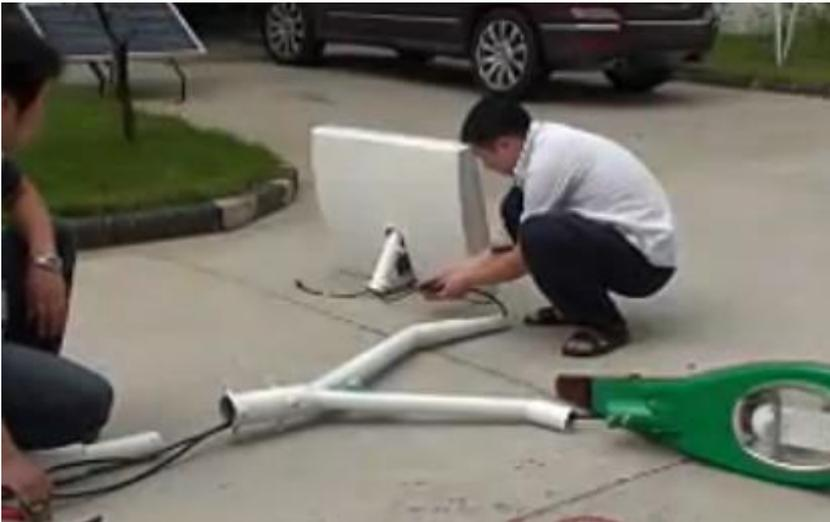
第三部、接插太阳能路灯有电线与延长电线，套入 LED 灯，调整好角度，确保 LED 灯能直接照射路面。
