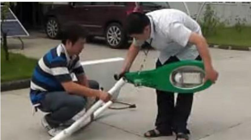
第四部、套入太阳能路灯光伏支架，注意调整角度，确保太阳能电池板能接受更多的阳光照射，锁紧螺丝，固定 LED 灯与光伏组件支架。
