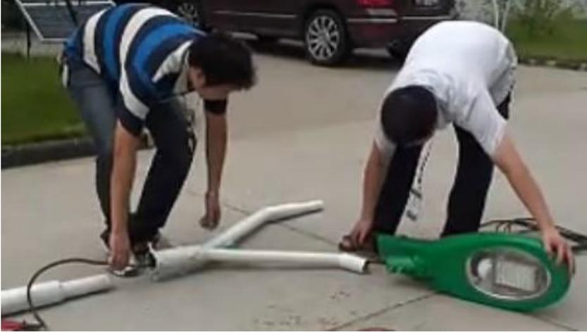
第二步、将太阳能路灯延长电线穿过 Y 型支架的树形分支。
