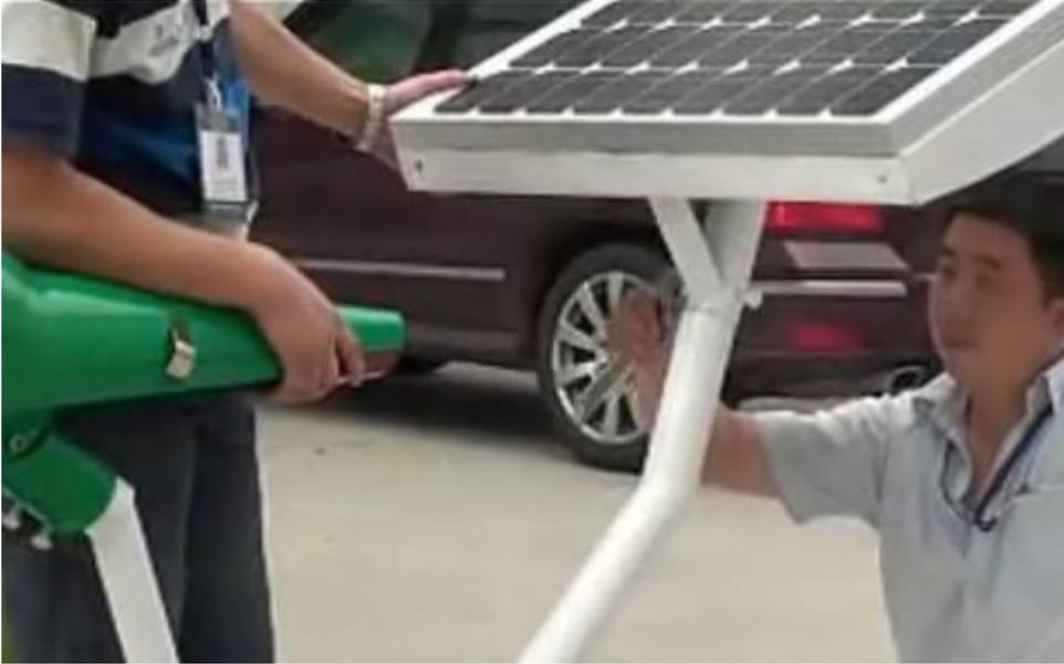
太阳能路灯光伏组件支架部分就安装完毕，需要注意的是螺丝要锁紧，固定好，才能承受大风天气，太阳能电池板的角度要调校好，才能吸收更多的阳光。感谢太阳能路灯权威品牌门户网提供的技术和资料支持，学习更多的太阳能路灯安装知识欢迎访问 <http://www.tyn18.com>。
