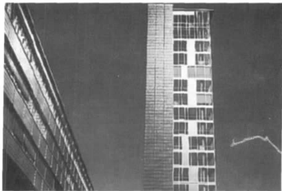
图4 商用光伏建筑一体化
