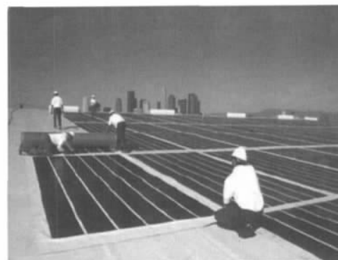
图 11 太阳能电池为材质的屋顶薄膜
