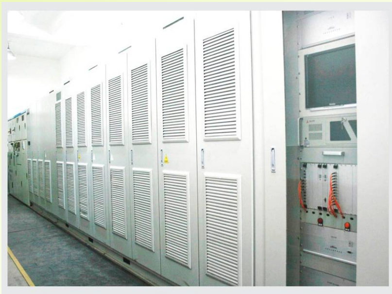
UPFC工程照片
