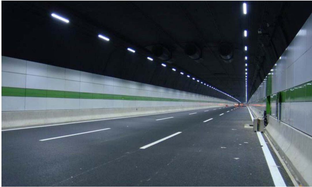
图 7: 上海长江隧道通车后的实景照片
