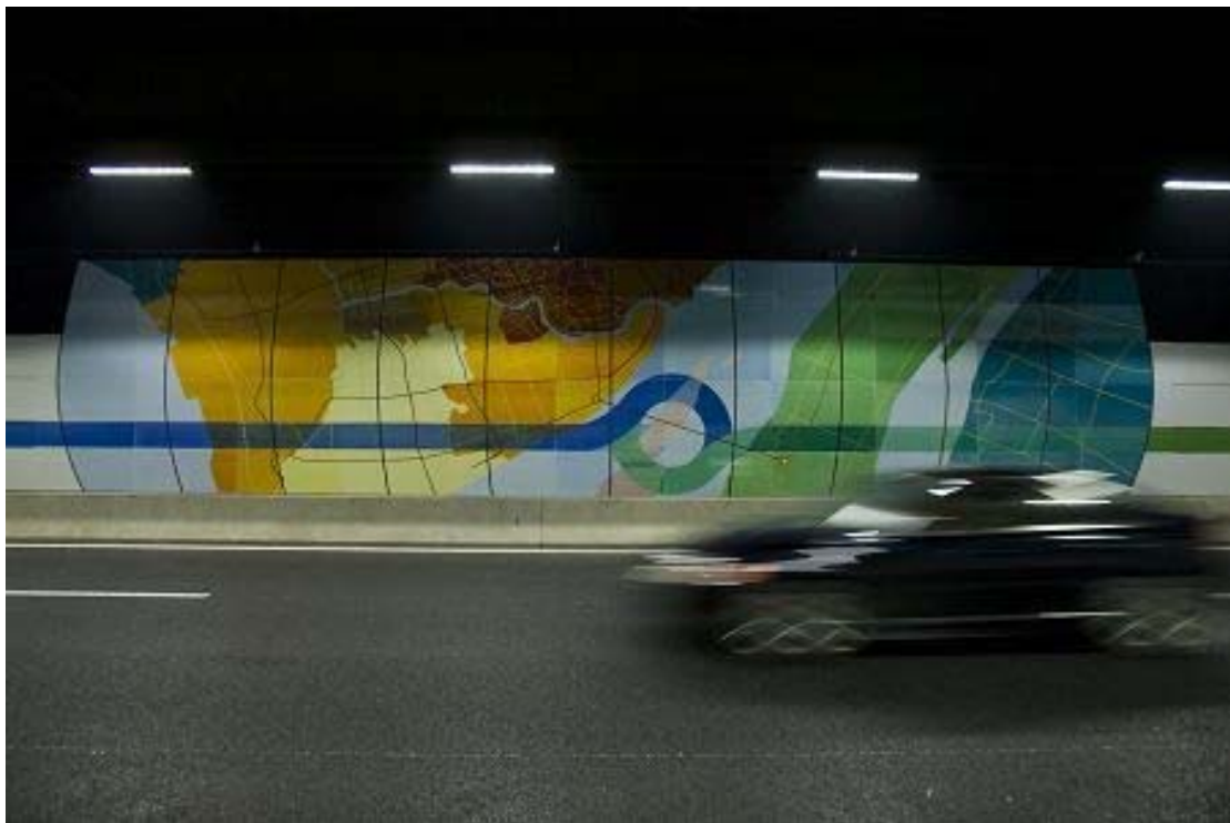
图 8: 上海长江隧道 LED 照明效果实景照片
