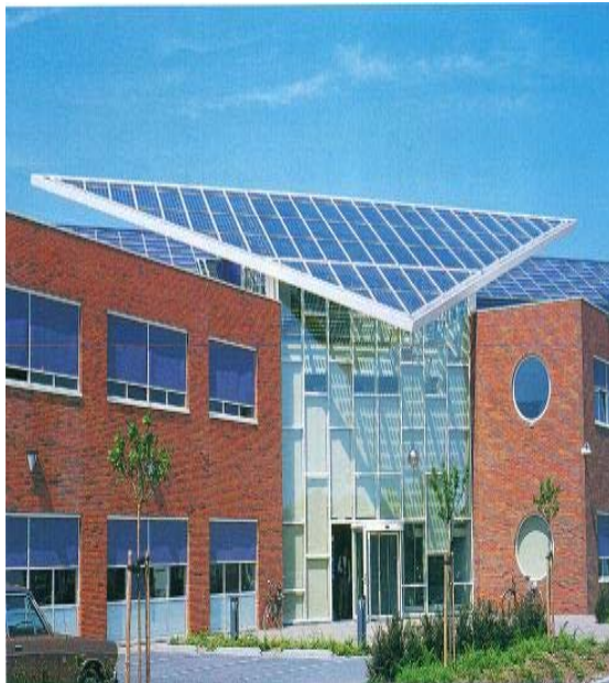
图 3 装设性的光伏屋顶
