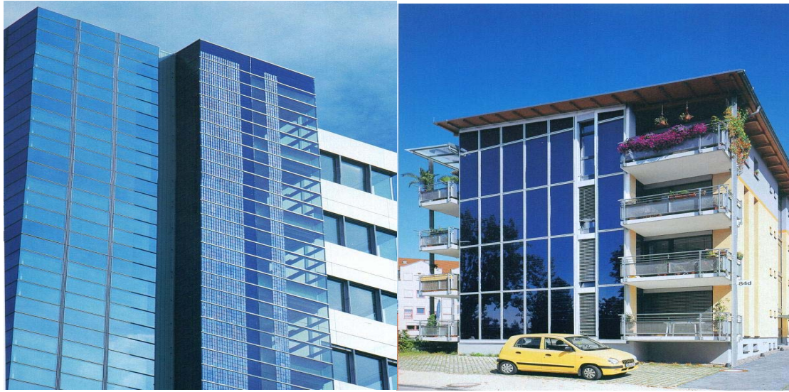
图 2 光伏和光热幕墙的应用
