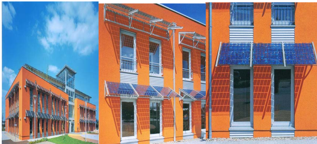
图 1 光伏组件可发电也具有遮阳挡雨功能
