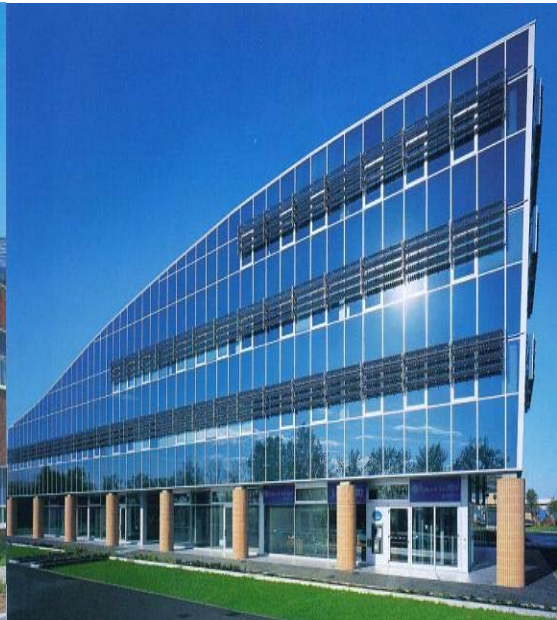
图 4 装饰性的光伏幕墙
