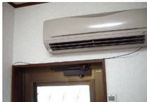
走空调排水管
