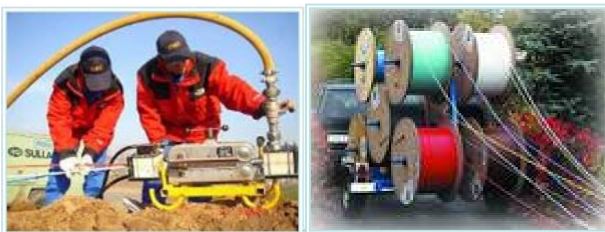
图4-20 气吹微缆和微管技术
