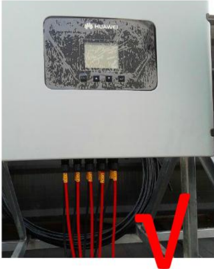
直流进线使用软线，无应力
